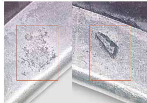
▲ Dichtungsschäden durch Schmutz und Fremdpartikel.
